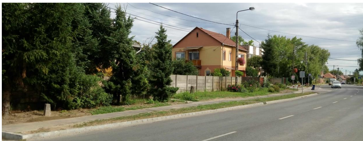
38. kép: Tervezett járda felújítás helyszíne.
