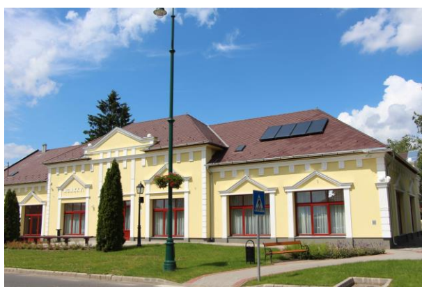
12. kép: Felújított Régi Kaszinó Étterem
